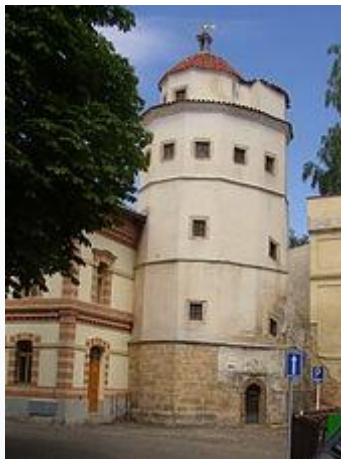
Turecká věž – někdejší městská vodárna z roku 1597
